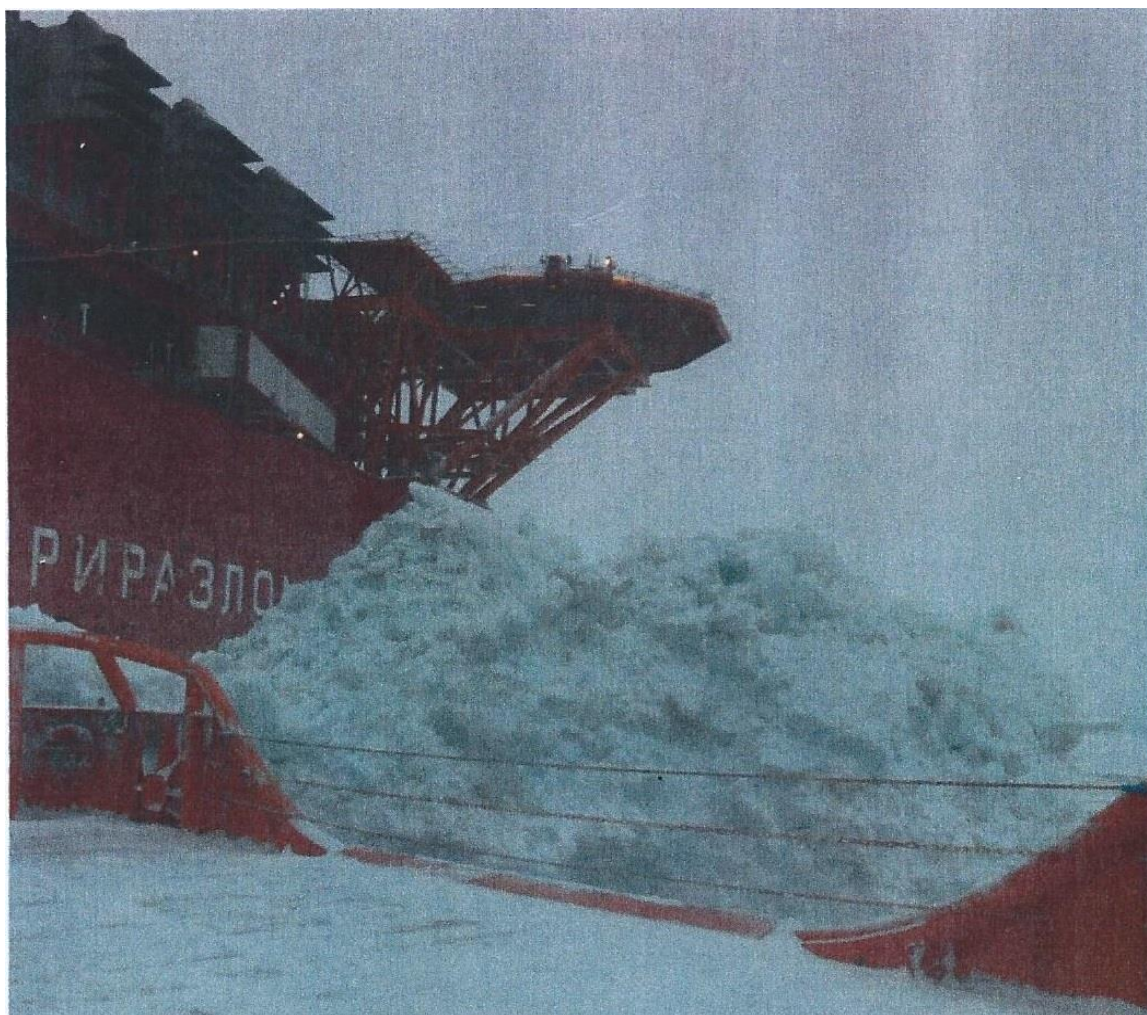
Рисунок 1. Влияние ледового нагромождения на конструкцию платформы
